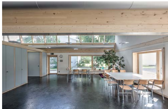
Gruppenraum im Neubau des Schulhauses Hirzbrunnen mit dem in Shed-Bauweise realisiertem Dach.
